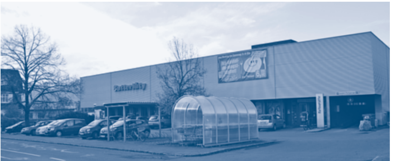
Das alte Sutterlüty-Gebäude soll noch heuer abgerissen und im Frühling 2018 durch einen Flagship-Store ersetzt werden.
