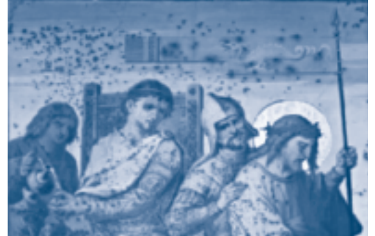
Gut zu erkennen: Die Korrosionsstellen an der ersten Kreuzwegstation in der St. Michael-Kirche.
