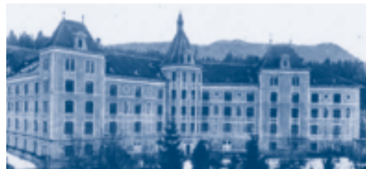
Der „Türmlebau“ der Wohltätigkeitsanstalt wurde in den Jahren 1885 bis 1887 errichtet. Im Frühjahr 1973 musste er im Zuge der „Generalsanierung der Landes- Heil- und Pflegenstalt Valduna“ weichen, um den Neubau der Psychiatrie I zu ermöglichen.
